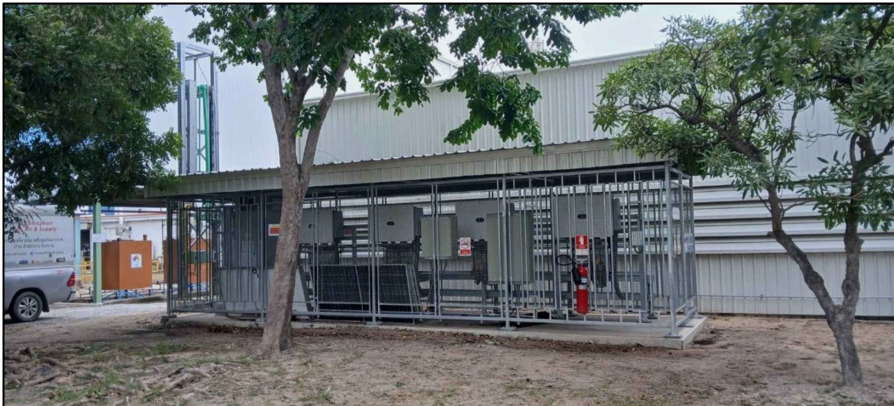
ภาพที่ 1.7 การติดตั้งเครื่องแปลงกระแสไฟฟ้า (Inverter) บริเวณด้านหลังอาคารสายการผลิตแผ่นเหล็กเคลือบโลหะ 1 (MCL1)
